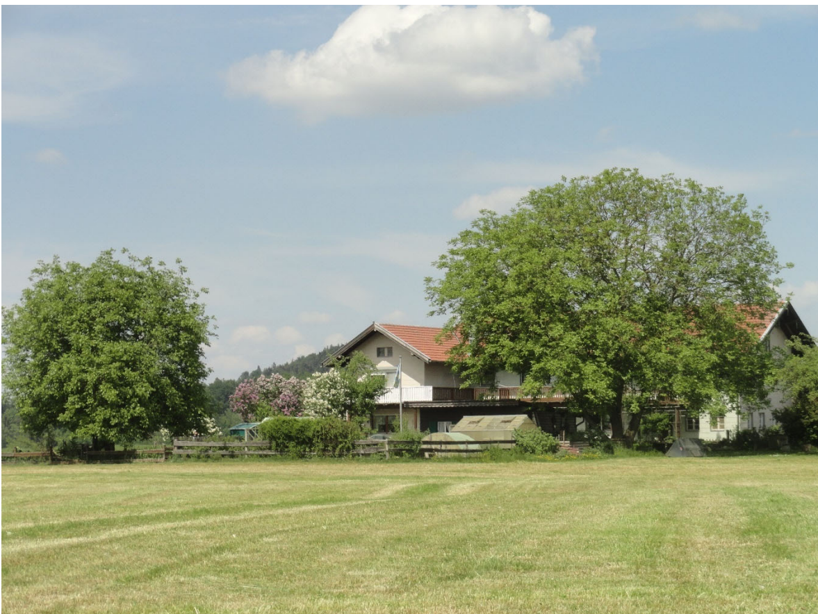
B_Blick auf das westliche Bestandsgebäude (Parzelle 12-14)
