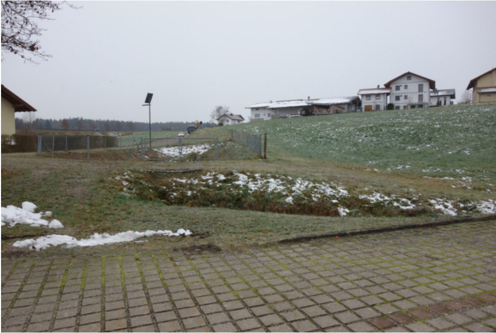
Bild: Im Vordergrund der Graben, im Hintergrund, umzäunt, das Regenrückhaltebecken
