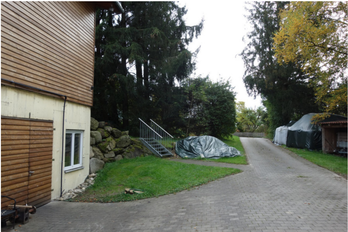
Blick in die Zufahrt Richtung Pfarrer Geigl Str. , links: bestehende Heizkraftanlage mit Baumgruppe, rechts: Lagerfläche unter alten Fichten
