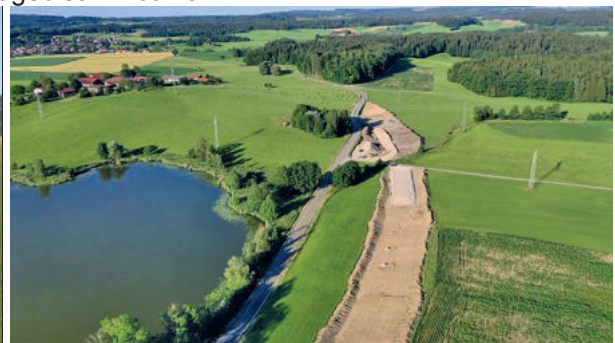
Neubau Staatsstraße Wasserburg - Babensham
